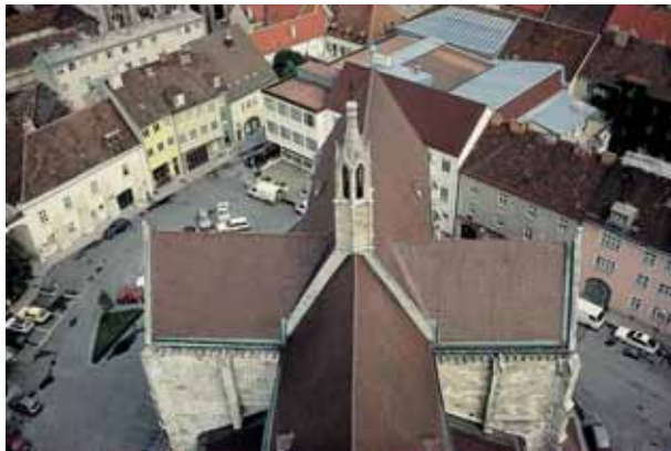
Abb. 11: Achsknick des Domes am Dachfirst (gotischer Knick)
