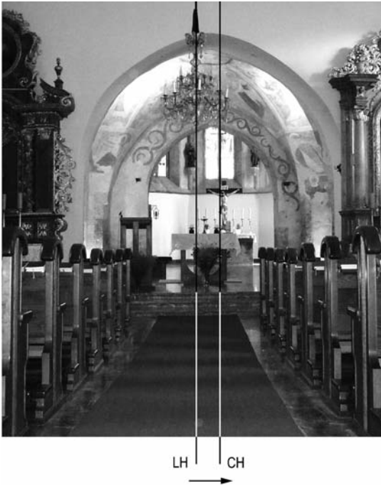
Abb.4 (oben): Pfarrkirche Muthmannsdorf, NÖ, Achsknick nach Süden (romanische Achse bei gotischem Chor übernommen), Knickwinkel 5.06^\circ . Legende Abb. 2.
