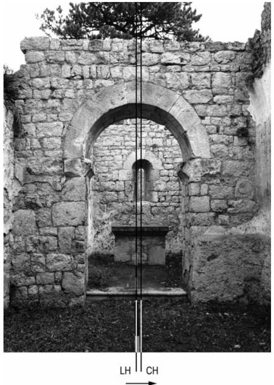
Abb.4 (oben): Pfarrkirche Muthmannsdorf, NÖ, Achsknick nach Süden (romanische Achse bei gotischem Chor übernommen), Knickwinkel 5.06^\circ . Legende Abb. 2.
