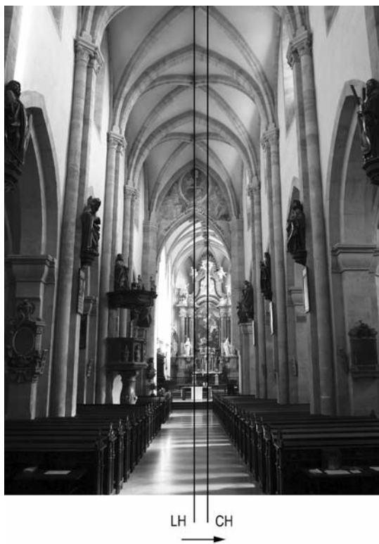
Abb.3: Dom zu Wiener Neustadt, Achsknick nach Süden (romanischer Achsknick bei gotischem Chor verstärkt), Knickwinkel 4.6° (romanisch 2.7°). Legende Abb. 2.
