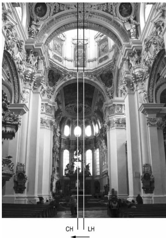
Abb.2: Dom zu Passau, Achsknick nach Nord (romanische Achse bei gotischem Chor übernommen), Knickwinkel 2.91°
